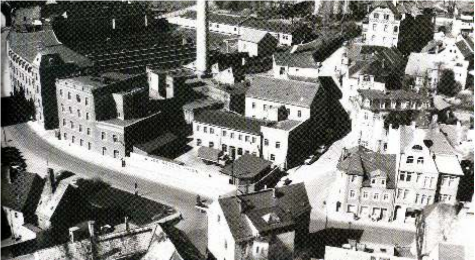
Blick vom Kirchturm auf das Gelände der Wäscheunion im Jahre 1989 / Quelle: Stadtverwaltung Mittweida
