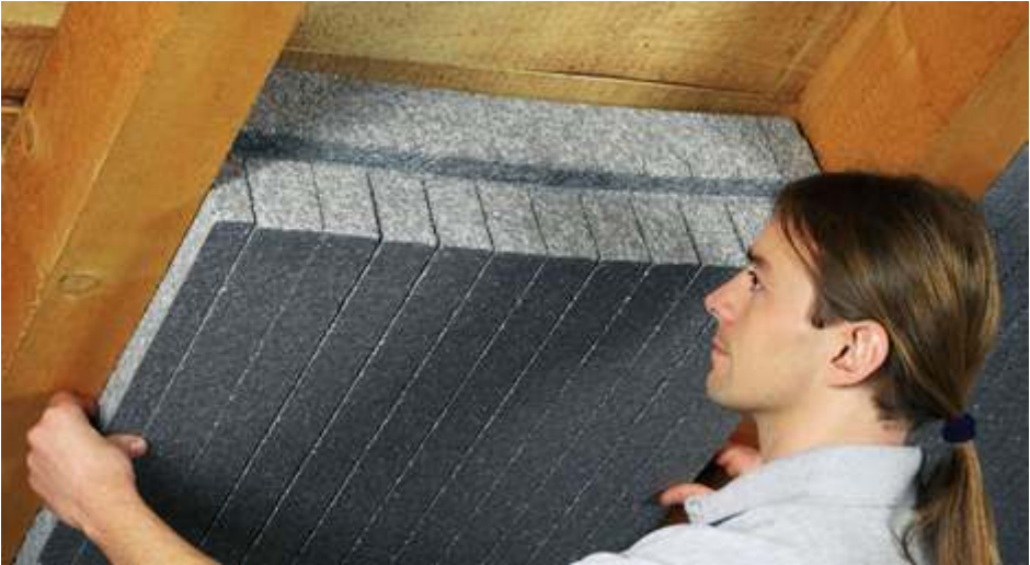
Ungedämmte Obergeschosse sind für einen Großteil der Wärme- und Energieverluste in Altbauten verantwortlich / Foto: djd/IVH
